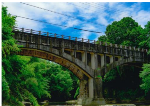
「森の中の御坂サイホン橋」 淡河川疏水(兵庫県三木市) 田中 泰一(兵庫県)
