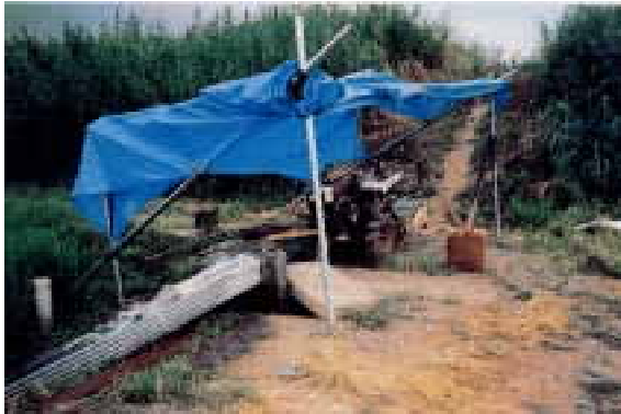
仮設揚水ポンプの設置（耕耘機の動力を利用） 用排水路が分離されている地域においては、排水路に各種の動力源による揚水ポンプを設置して水の反復利用を図った。
