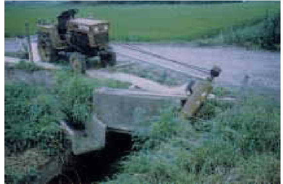
仮設揚水ポンプの設置（トラクタの動力を利用） 用排水路が分離されている地域においては、排水路に各種の動力源による揚水ポンプを設置して水の反復利用を図った。
