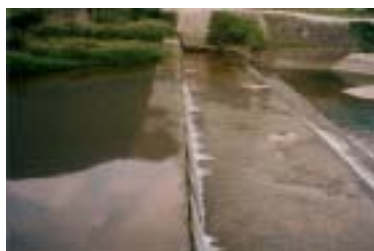
高戸谷頭首工
