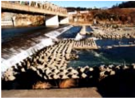
幹線水路（利根川横断暗渠）
