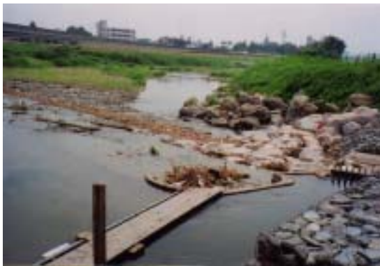
寺尾堰取水口
