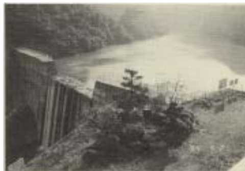
沼尾川砂防ダム
