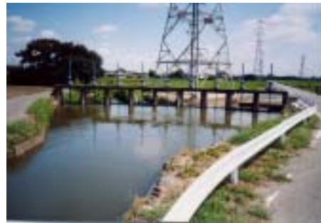
中村堰分水工
