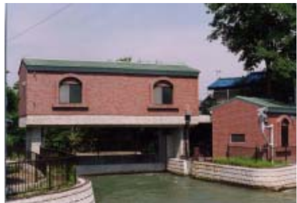
改修後の十六本堰
