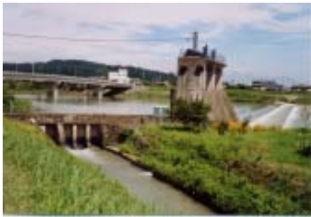
中村堰頭首工
