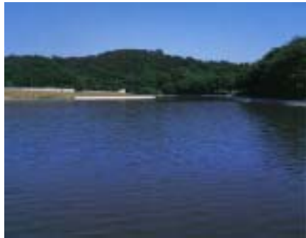
鹿の川沼調整池
