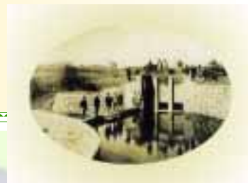
丹生川頭首工の工事 上流より(昭和15)
