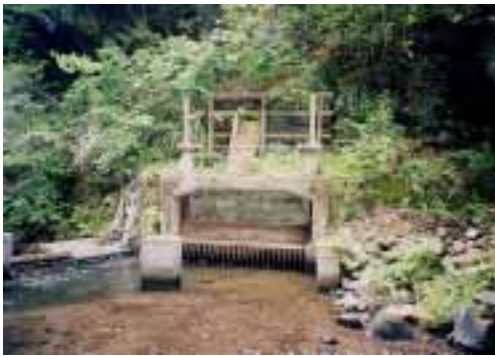
深沢川頭首工
