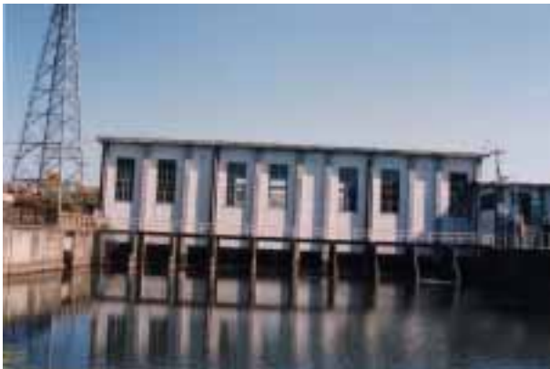
排水機場 概観状況
