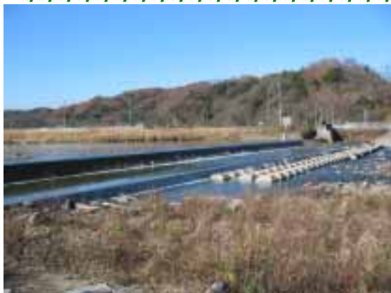
板鼻堰頭首工
