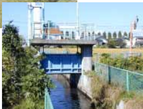
赤坂川分土工
