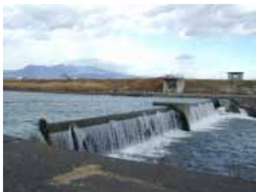
筑井堰頭首工
