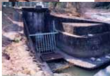
人見堰頭首工及び取水口
