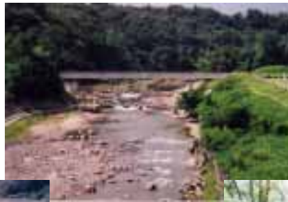
人見堰水路橋
