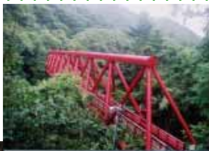
猿ヶ京水管橋
