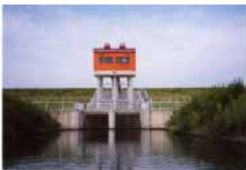
利根加揚水取水口
