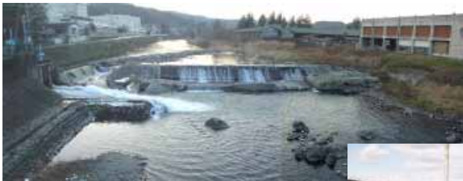
春日堰頭首工
