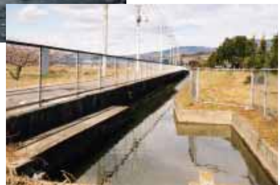
松原堰 管理道路と排水路
