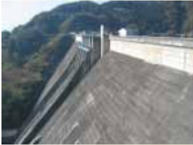
草木ダム全景
