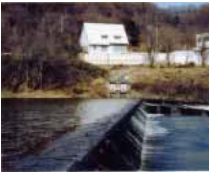
馬庭堰頭首工
