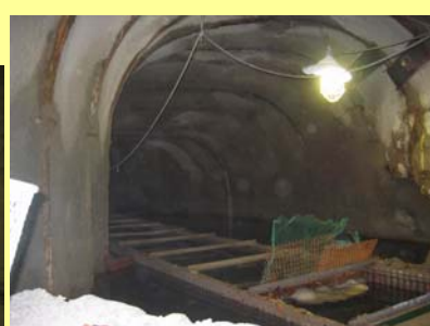
隧道内部見学②
