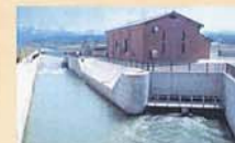
農業水利施設を活用した小水力発電
