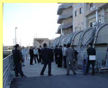
排水機場除塵機
