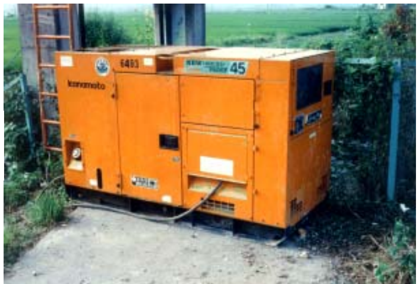
仮設ポンプ（2台） 設置にて汲み上げ （邑楽郡邑楽町石打地先）
