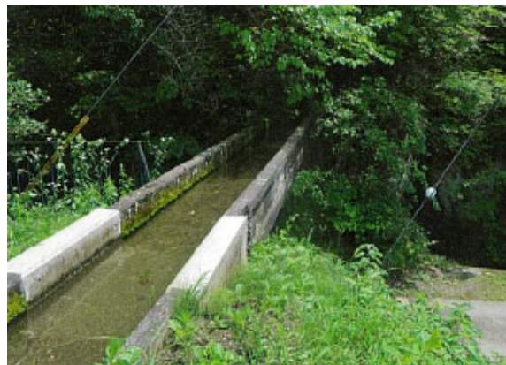
観音沢を渡る水路橋
