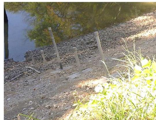
※ 斜樋による取水操作は堤体天端付近で行える。
